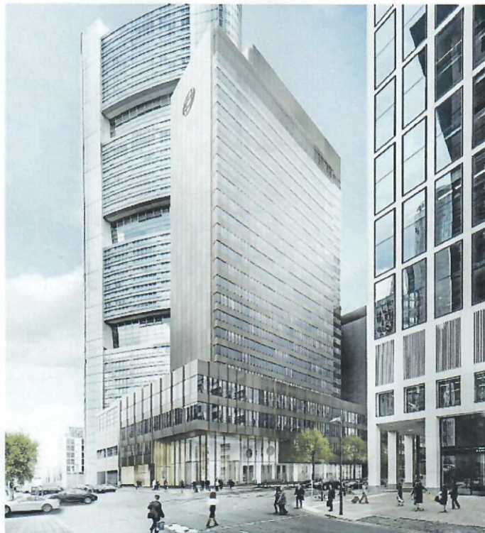
Das einstige Commerzbank-Hochhaus wird komplett erneuert.
